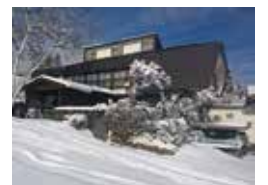
建物正面入口を少し降りると 駐車場があります。そこから 敷地に入ると冬期入口があります。
